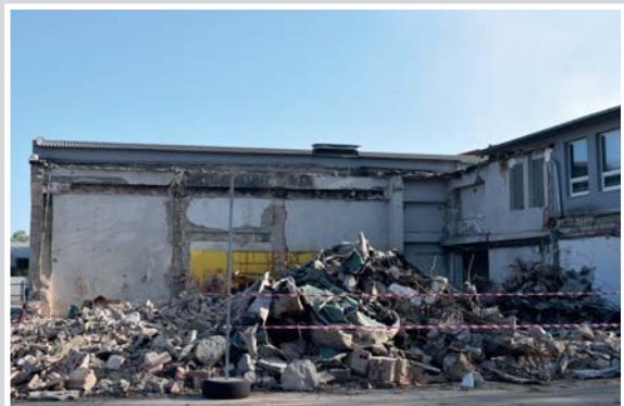
Demolice staré budovy, květen 2016
