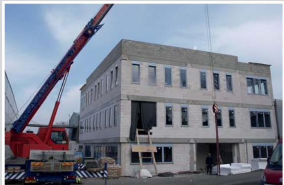
Výstavba nové budovy, jaro 2017
